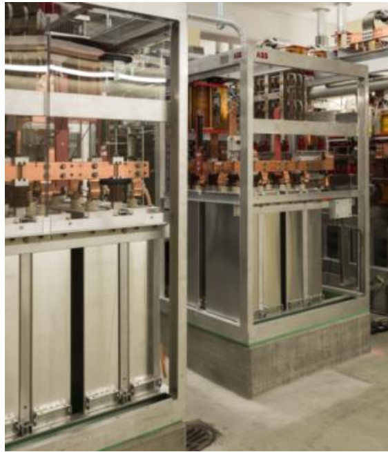
Frequenzumrichter Zwischenkreisfilter
