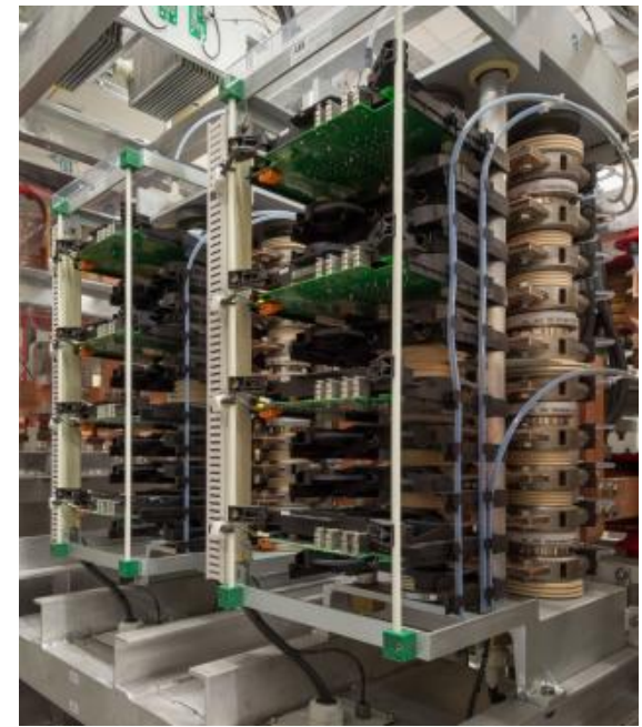
Frequenzumrichter Spannungsbegrenzer
