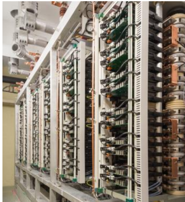
Frequenzumrichter Leistungsteil
