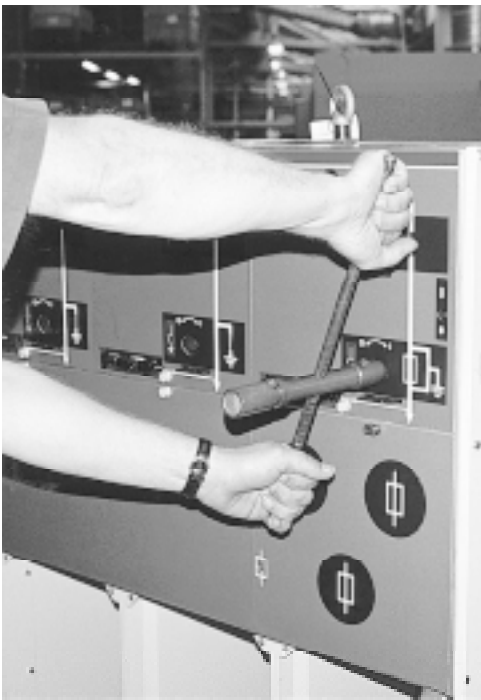
2. Fermer le sectionneur de terre (tourner le levier dans le sens horaire).
