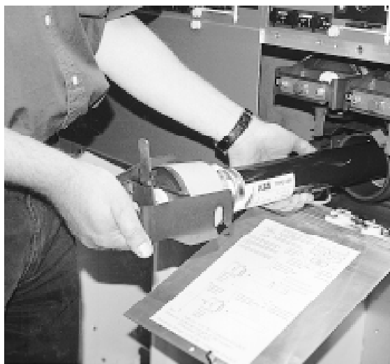
6. Sortir le bouchon. Le fusible est fixé au bouchon.
