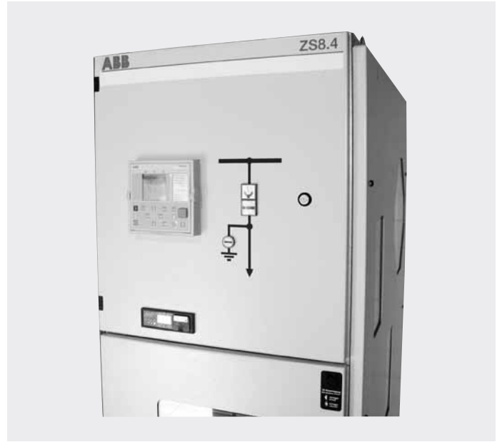
Bild 6/2: Feldleit- und Schutzgerät REF542 plus sowie Spannungsmessbuchsen an der Tür eines Niederspannungsraumes (Beispiel).
