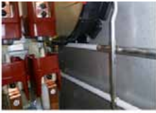
Schiebeplatte am Anfang der Schaltbewegung
