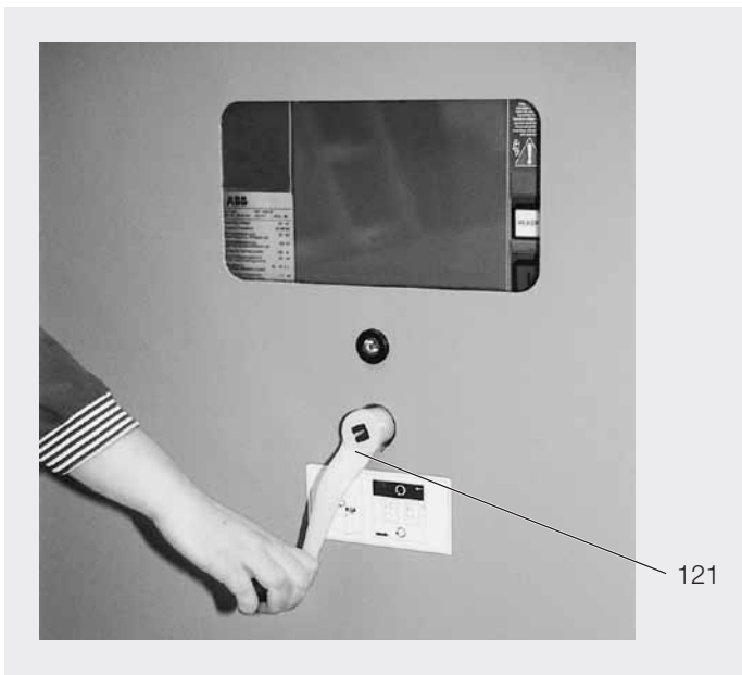
Bild 6/5: Verfahren des Leistungsschalters auf Einschub zwischen Prüf-/Trennstellung und Betriebsstellung; rechtsdrehend bis zum Anschlag zur Betriebsstellung bzw. linksdrehend zur Prüf-/Trennstellung. 121 Handkurbel
