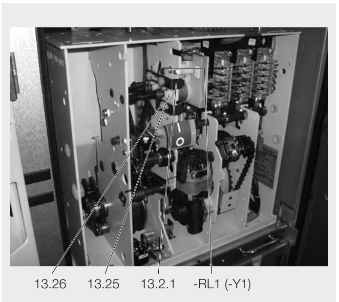
Bild 7/5: Detailbereich Ein- und Ausschaltmechanik. 13.2.1 Ein-Druckstange 13.25 Kunststoffnocken 13.26 Hebel -RL1 Sperrmagnet
