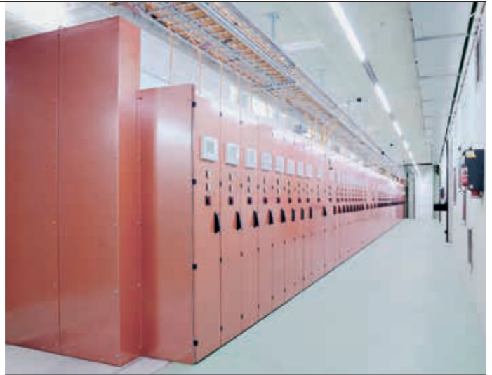
3b Mittelspannungs-GIS für 24 kV
