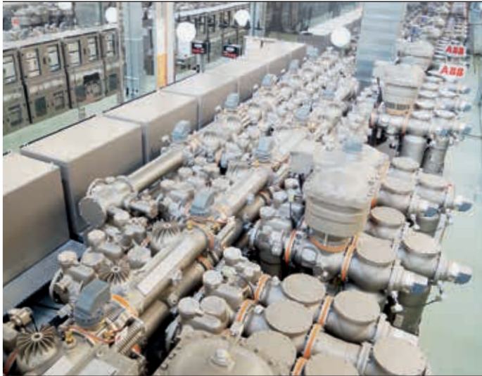
3a Hochspannungs-GIS für 170 kV
