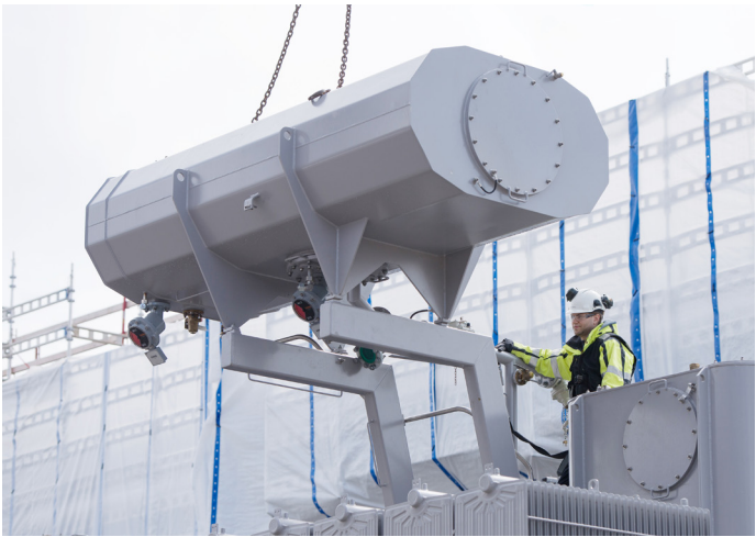
Fra installasjonen av en av transformatorene til ABB ved den nye omformerstasjonen som er plassert på Kollsnes i Hordaland.
