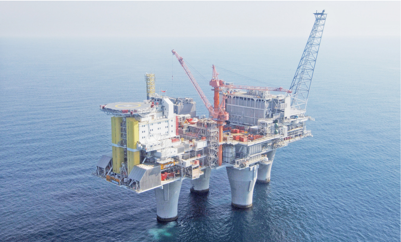
Til Troll A-plattformen har Statoil to ganger valgt kraft fra land med ABBs likestrømssystem, HVDC Light, for å drive gasskompressorer om bord. Elektrifisering er klima- og kostnadseffektivt og representerer dermed snarveien til en mer bærekraftig og lønnsom olje- og gassindustri.
