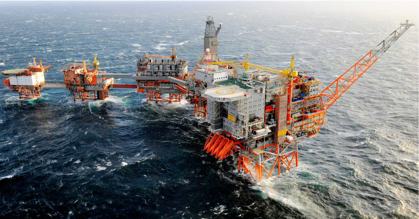
Hele Valhall-komplekset til BP får kraft fra land gjennom et 292 kilometer langt HVDC Light-system fra ABB.
