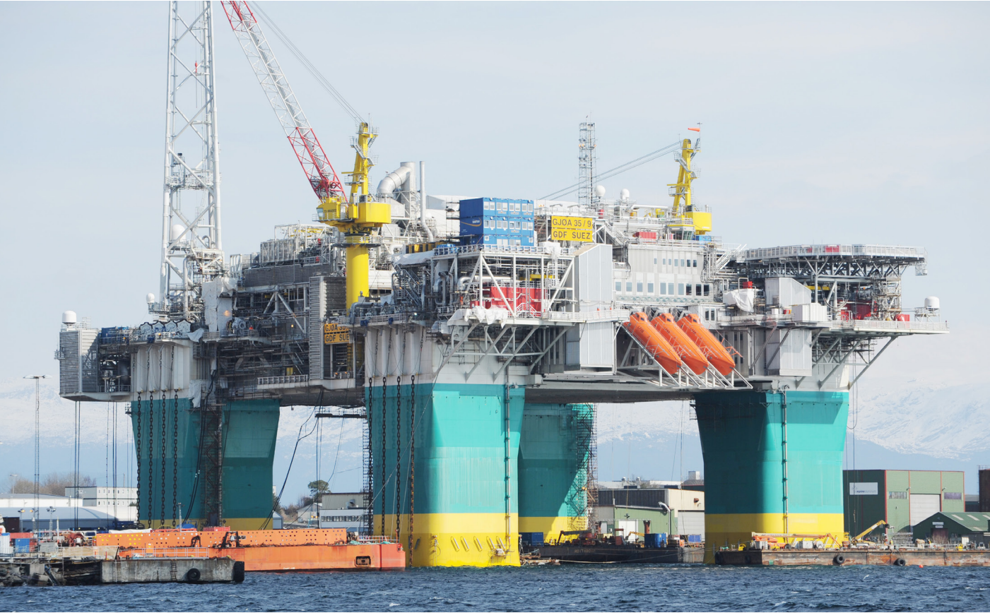
Gjøa-plattformen, her under klargjøring på Stord, får kraft fra land gjennom en 100 kilometer lang vekselstrømsforbindelse med Mongstad i Hordaland.
