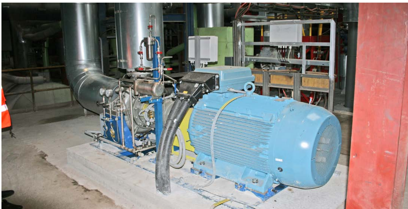
Čerpadlo, hydrospojka a motor regulovaný frekvenčným meničom od ABB pomáhajú dodávať väčšinu všetkého tepla pre Martin a okolie
