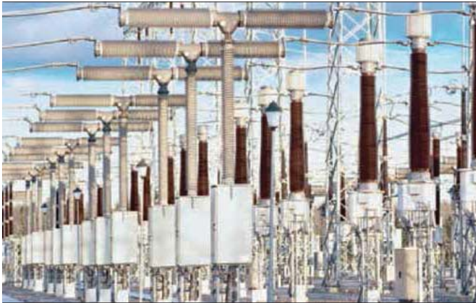
รูปที่ 4 ดิสคอนเนคติ้งเซอร์กิตเบรกเกอร์
