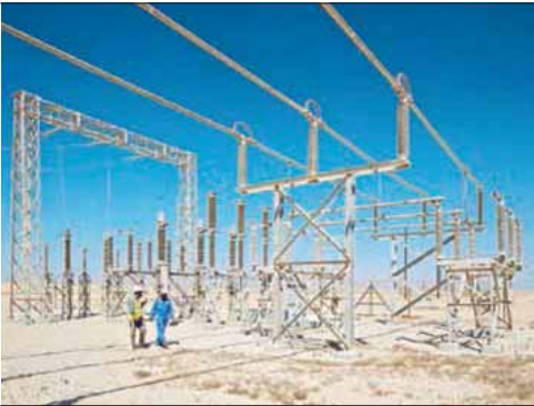
รูปที่ 2 อุปกรณ์ไฟฟ้าแรงสูงตัวฉนวนคอมโพสิต
