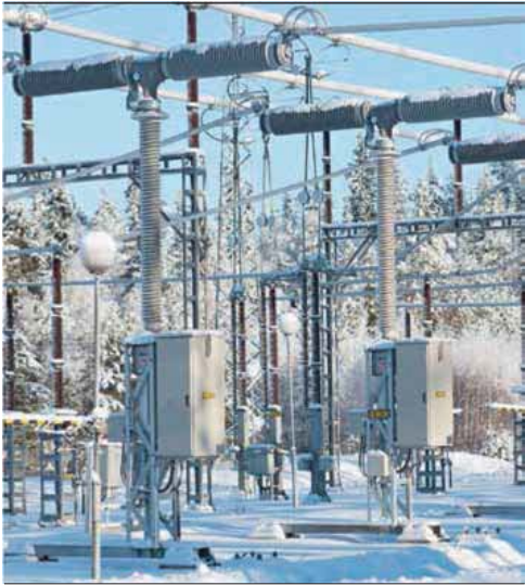
รูปที่ 6 DCB และ FOCS ณ สถานที่ติดตั้ง
