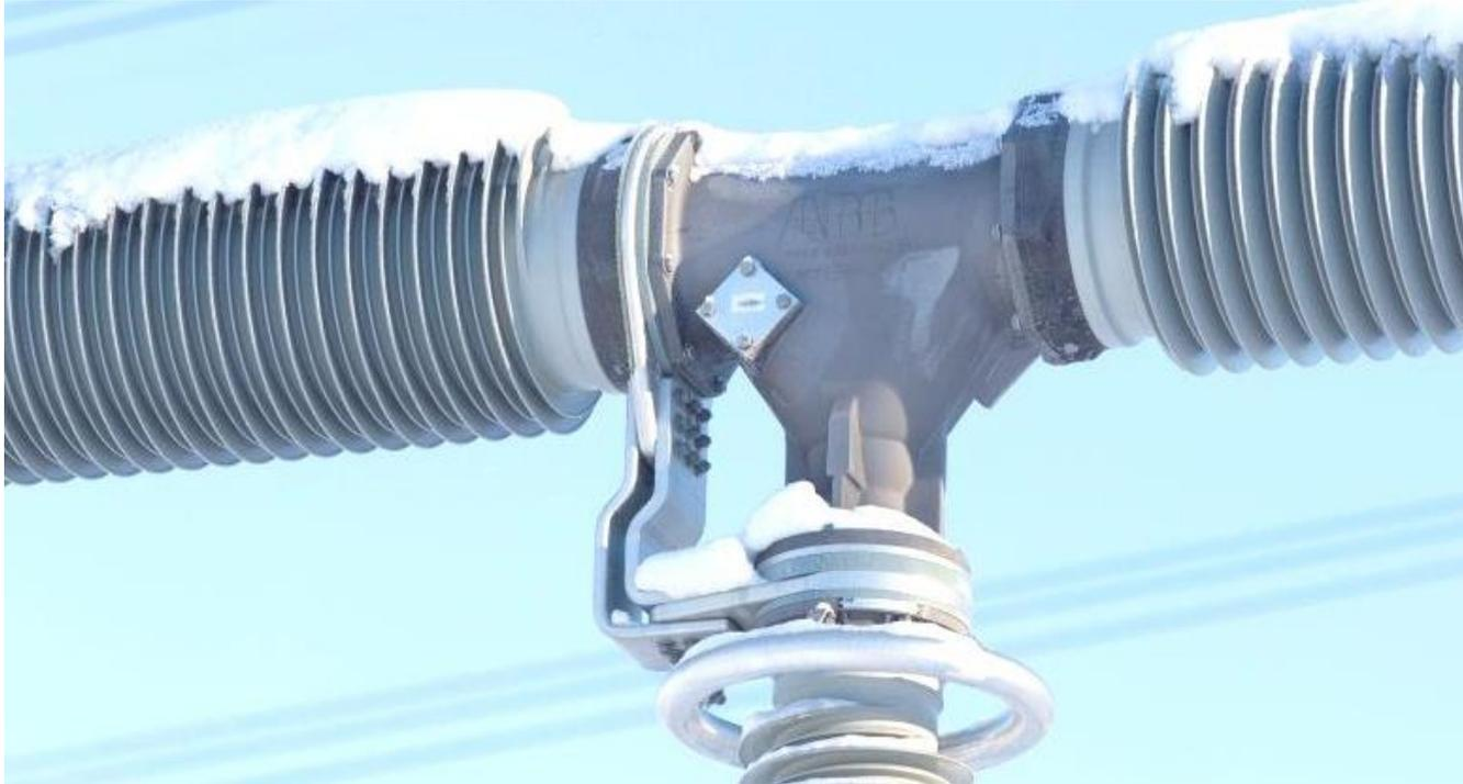
Con un interruptor seccionador DCB se puede tener una bahia completa en un solo equipo.
