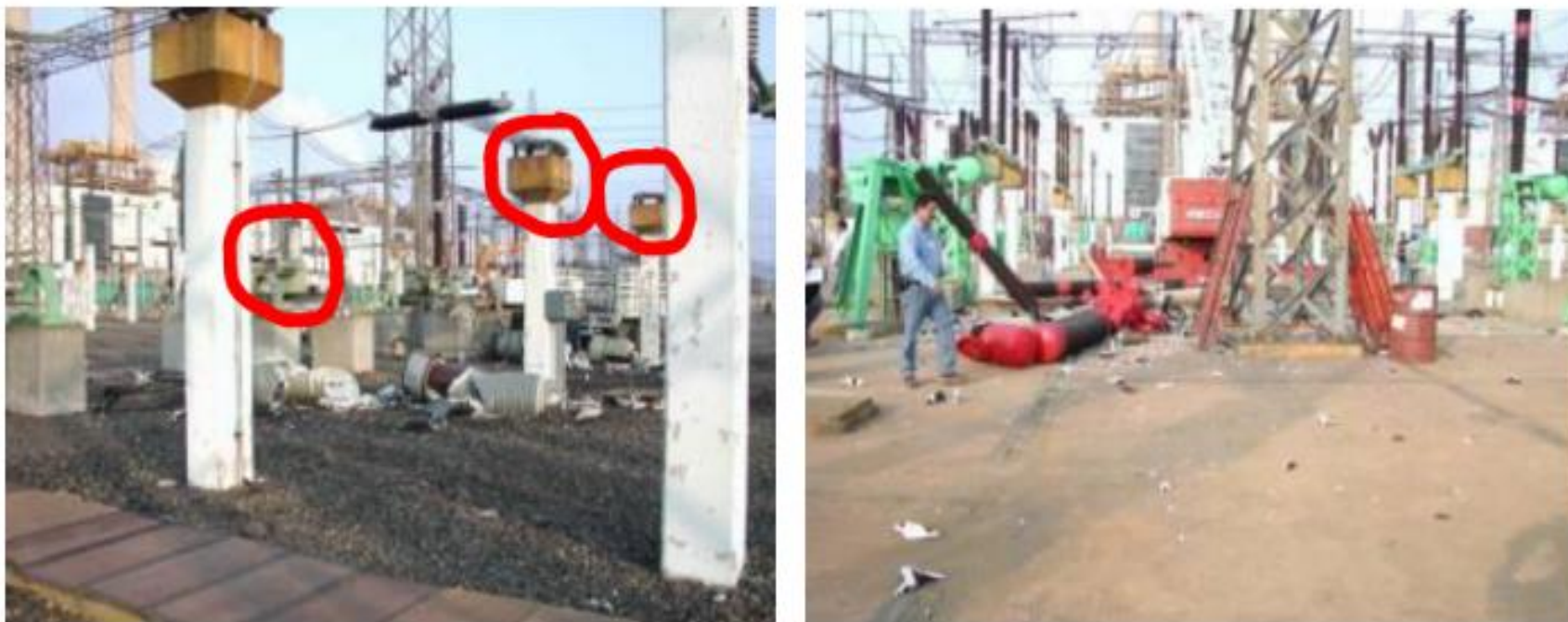
Figura 15 Colapso de Transformadores de Potencia (TP) de 400 kV
