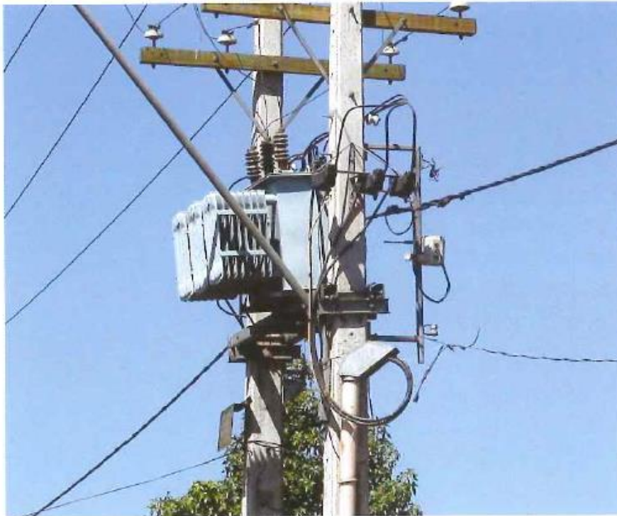
Fig. 3.20 Transformadores de media tensión aéreos fuera o desplazados de su base.
