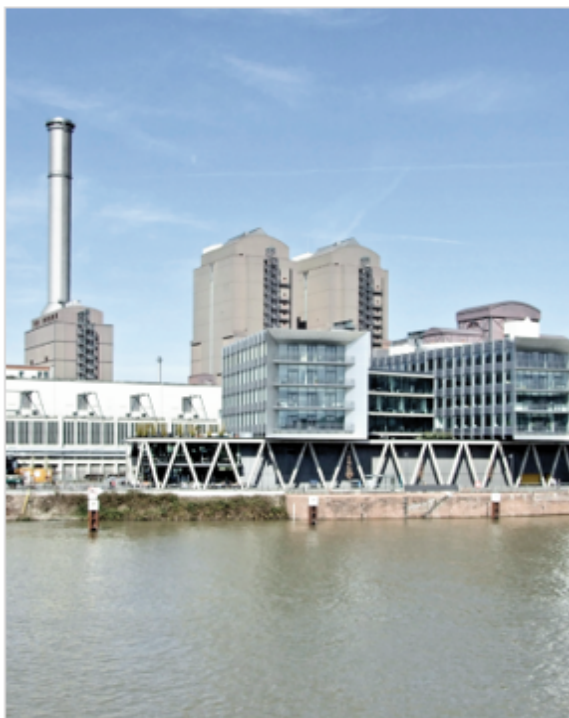
4 Mainova STPP HKW West 2
