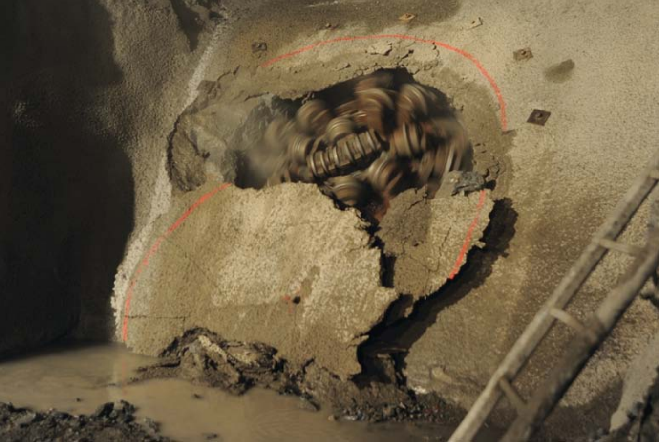
Durchschlag der Tunnelbohrmaschine im Wasserschloss Kapf
