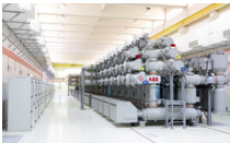
Installation isolée au gaz
