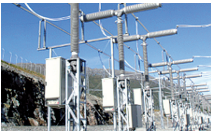
Installation isolée à l'air
