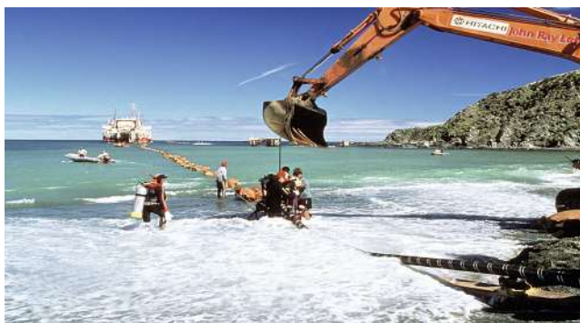
Kabelverlegung für die neuseeländische Interisland-Verbindung durch die Cookstrasse, 1985. Die Verbindung liefert Wasserkraft von der Südinsel zu den Verbrauchszentren im Norden.
