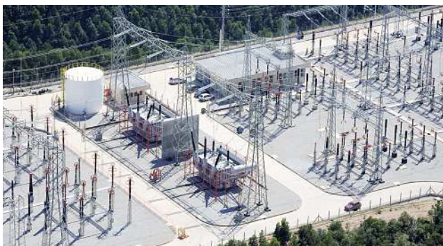
Die 440-kV-Unterstation mit luftisolierter Schaltanlage (AIS) wurde 2007 in der Nähe von São Paulo in Brasilien in Betrieb genommen.
