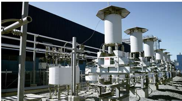
Eine SVC-Light-Installation in Finnland, 2005, stabilisiert die Spannung und wirkt Stromschwankungen entgegen.
