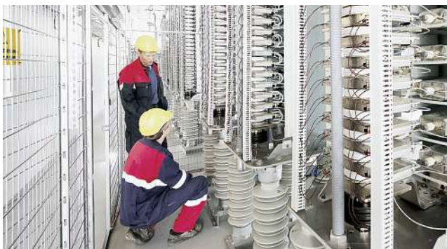
FACTS-Installation zur Deckung des wachsenden Strombedarfs in Norwegen. FACTS-Technologien können die Sicherheit, Kapazität und Flexibilität von Übertragungssystemen erhöhen.
