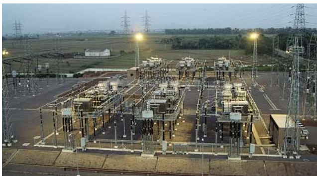
FACTS-Installationen in Raipur in Indien, die die effiziente Stromübertragung vom Osten in den Westen und Süden des Landes ermöglichen.
