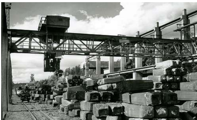
Ein magnetischer Brückenkran in Fagersta Bruks AB, Schweden. Der Kran hat eine Spannweite von 30 m und eine Lastkapazität von bis zu 12 Tonnen (1950er Jahre).
