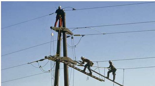
Ingenieure integrieren Glasfaserkabel in existierende Überlandleitungen für das Schweizer Elektrizitätswerk EKZ, 2006. ABB-Kommunikationsausrüstung wird weltweit genutzt, um Gespräche, Daten und Schutzsignale via Hochspannungsleitungen zu übertragen.
