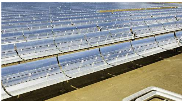
Das System 800xA steuert Parabolspiegel in Europas grösster thermischer Solaranlage Andasol in Südspanien. Die Bewegung der Sonne über den Himmel zu verfolgen, garantiert maximale Produktivität.
