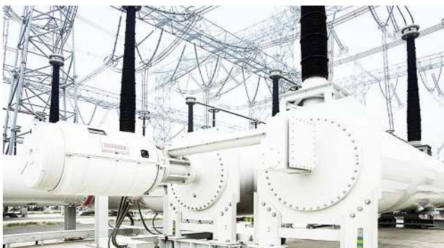
2009 nahm ABB gasisierte Schaltanlagen für Ultrahochspannung (1100 kV) in Betrieb und erhöhte mit dieser rekordbrechenden Installation die Effizienz der Stromübertragung über grosse Distanzen deutlich.
