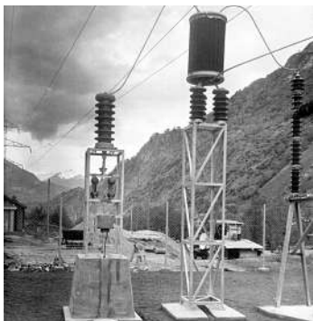
Eine von ABBs ersten Kommunikationsinstallationen, ca. 1944. Die Ausrüstung erlaubte es Netzbetreibern, Signale über ihre Stromleitungen zu übermitteln.
