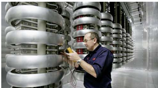
Ein Techniker von ABB testet HGÜ-Light-Ventile im Rahmen des Projekts zur Anbindung des Windparks Borkum 2 ans deutsche Stromnetz, 2009. Der Park befindet sich 125 km vor der deutschen Küste.
