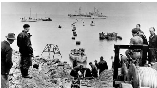
Das Gotland-Kabel wird 1950 an Land gezogen. Es verbindet die Insel mit dem Stromnetz auf Schwedens Festland und unterstützt so die Entwicklung der Wirtschaft auf der Insel.
