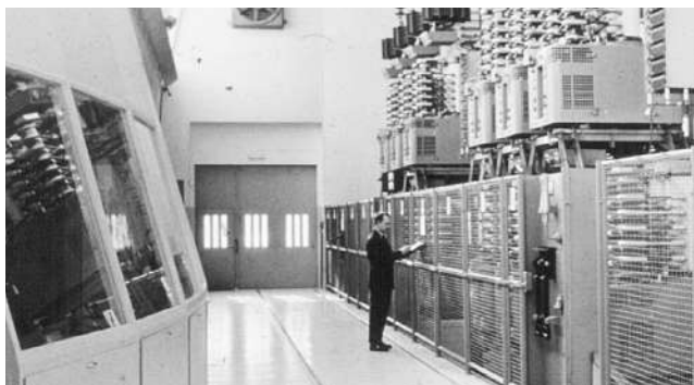
Ein Techniker von Asea in der Gotland-Ventilhalle, Teil des weltweit ersten kommerziellen HGÜ-Übertragungssystems, das 1954 betriebsbereit war.
