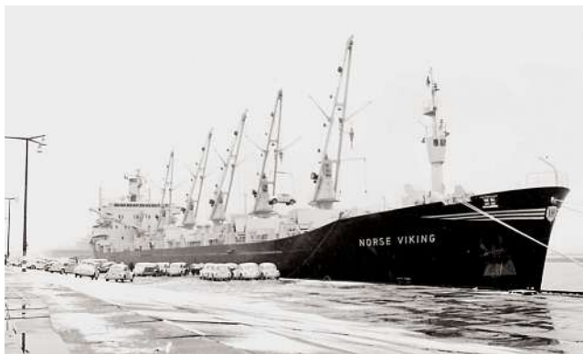
Die «Norse Viking» war mit sechs, elektrohydraulischen, programmierbaren 8-Tonnen-Deck-Kränen ausgerüstet (späte 1970er Jahre).
