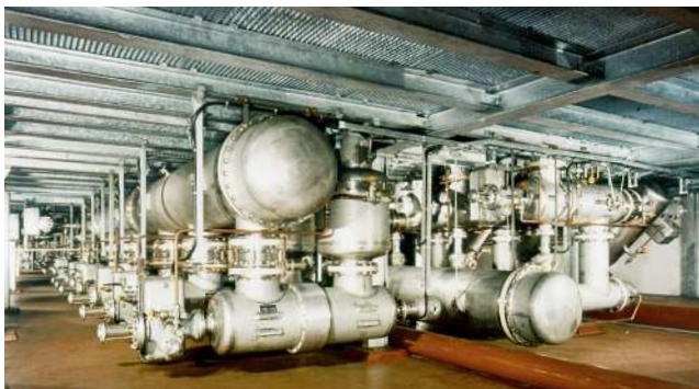
Eine der weltweit ersten GIS-Installationen in Sempersteig, Schweiz. Lieferung 1966, Inbetriebnahme 1967.
