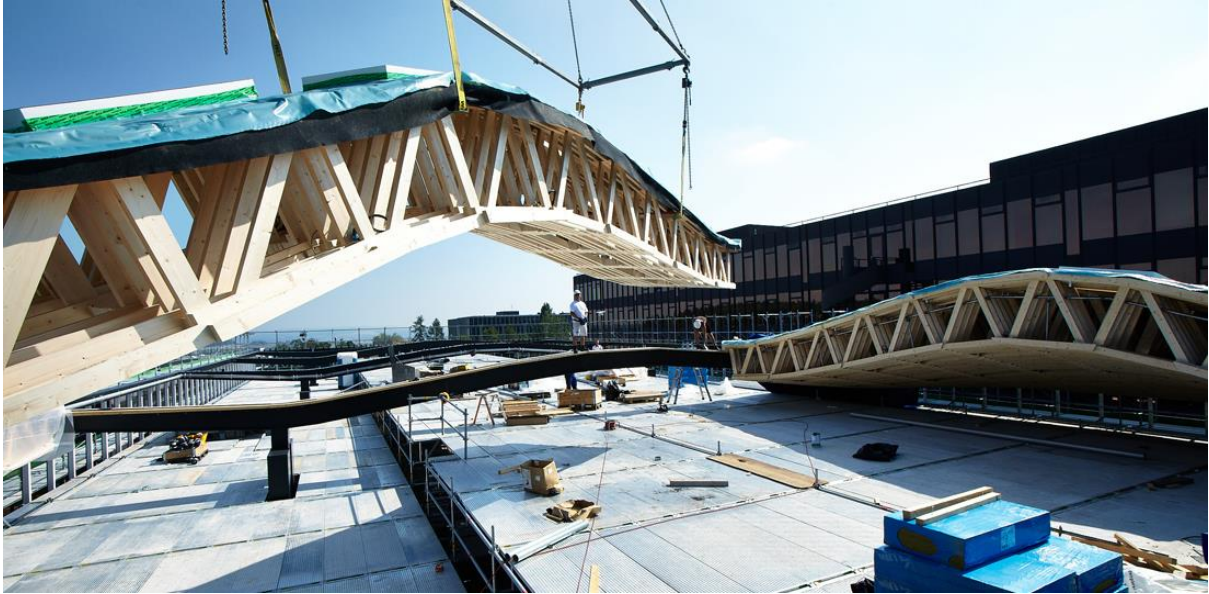
Montage des Holzdaches © Arch_Tec_Lab 2015, www.espazium.ch
