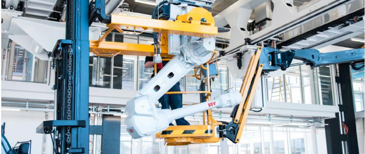
Das RFL im Aufbau: Montage eines ABB-Roboters © Gramazio Kohler Research ETH Zürich 2016
