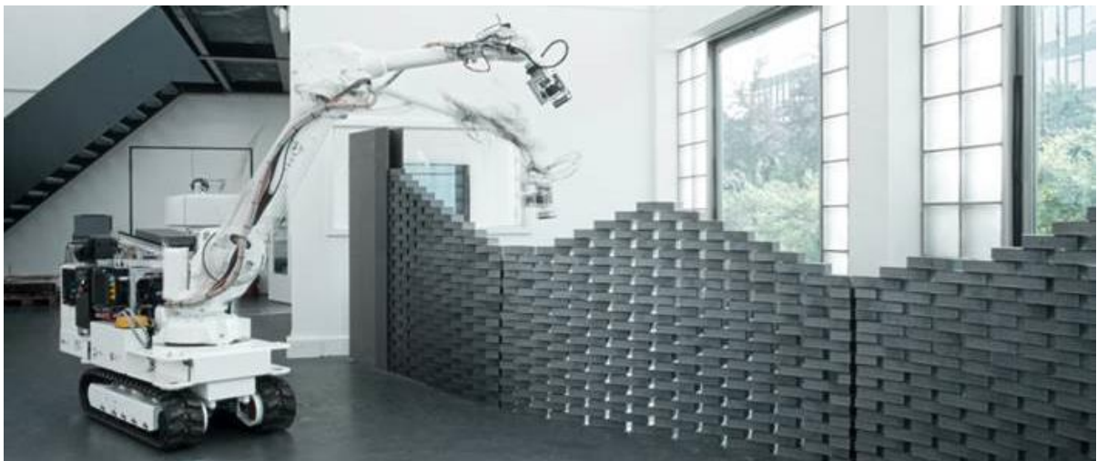
Additives Bauen mit ABB-Roboter ©NCCR Digital Fabrication, Gramazio Kohler Research ETH Zürich
