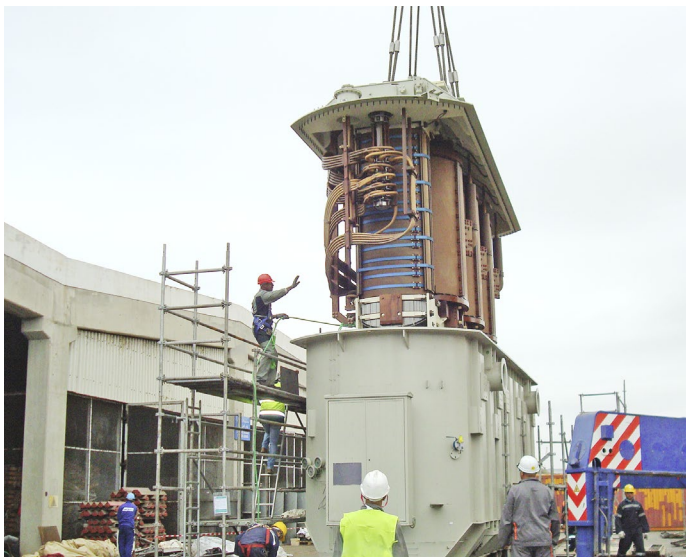
Aktivteilaushebung in einem Kohlekraftwerk
