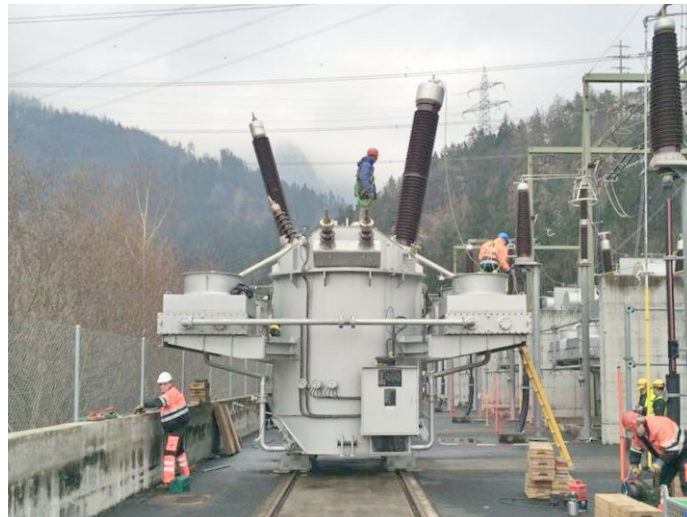
Montagearbeiten nach Werksreparatur
