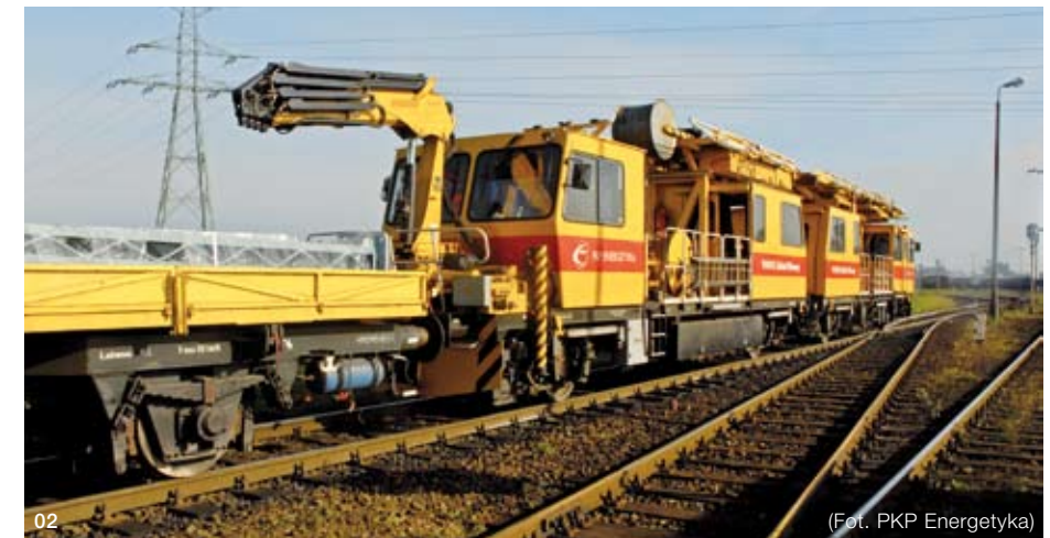
(Fot. PKP Energetyka)
