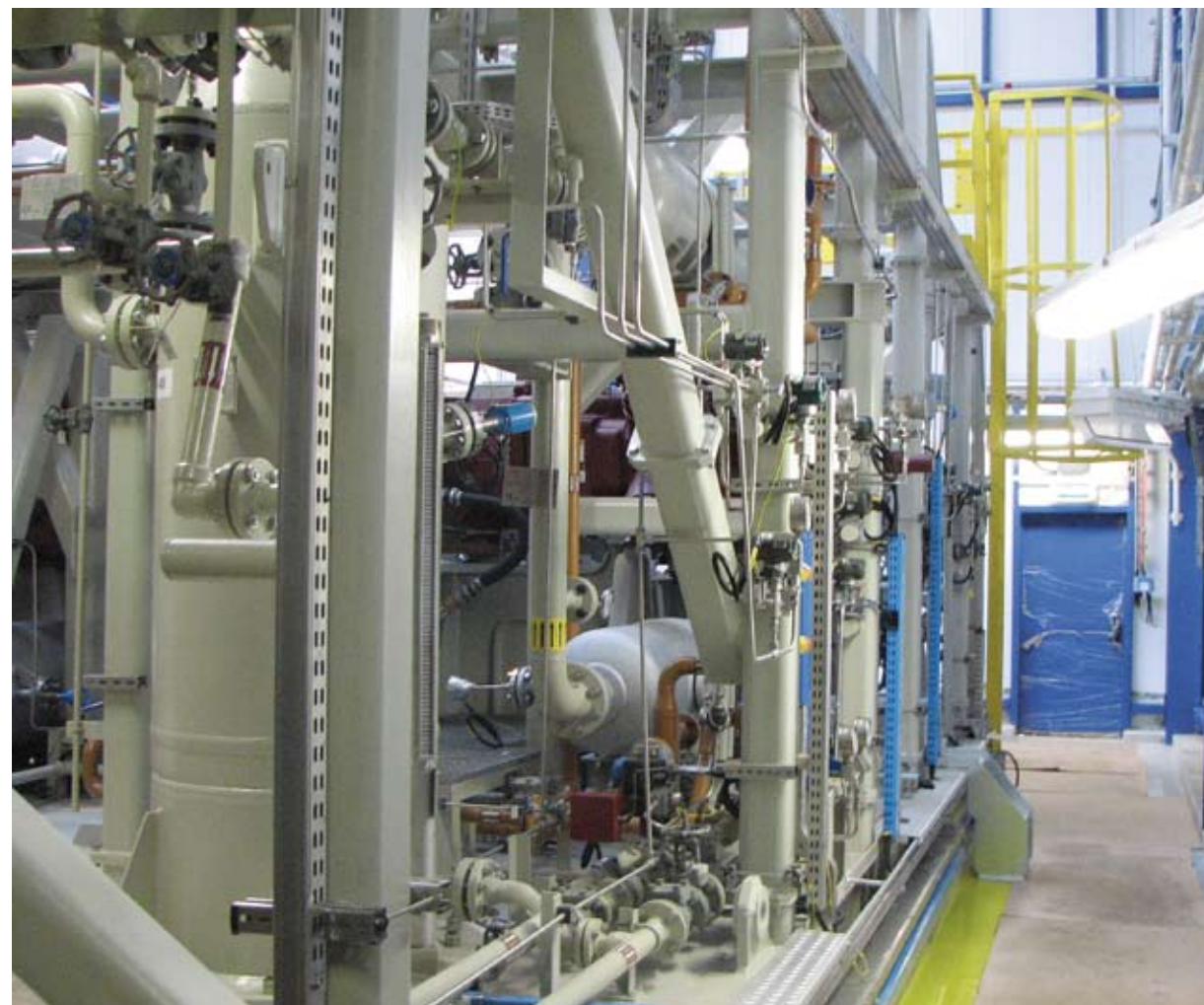
Kompresory gazu kwaśnego – zaprojektowane i zbudowane przez ABB – stanowią jeden z najważniejszych elementów całej instalacji. Gaz ten, zawierający kilkanaście procent siarkowodoru, pozwala bowiem na odzyskanie lekkich węglowodorów, niezbędnych w technologii związanej z przeróbką ropy naftowej. (Fot. Sławomir Cieślak)
