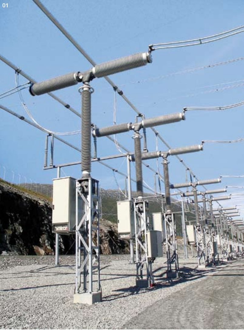
01 Napowietrzny wyłącznik HPL B 420 kV z napędem sprężynowo-silnikowym typu BLG. (fot. Arch. ABB)
