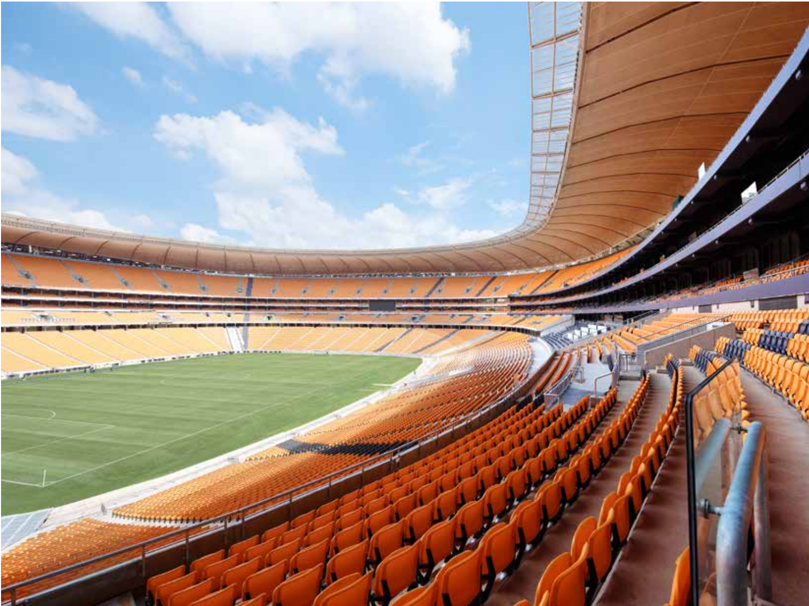
Soccer City Stadium w Johannesburgu był areną otwarcia i zamknięcia XIX Mistrzostw Świata w Piłce Nożnej w 2010 roku. Całą infrastrukturą energetyczną na tym obiekcie zarządza system SCADA firmy ABB.
