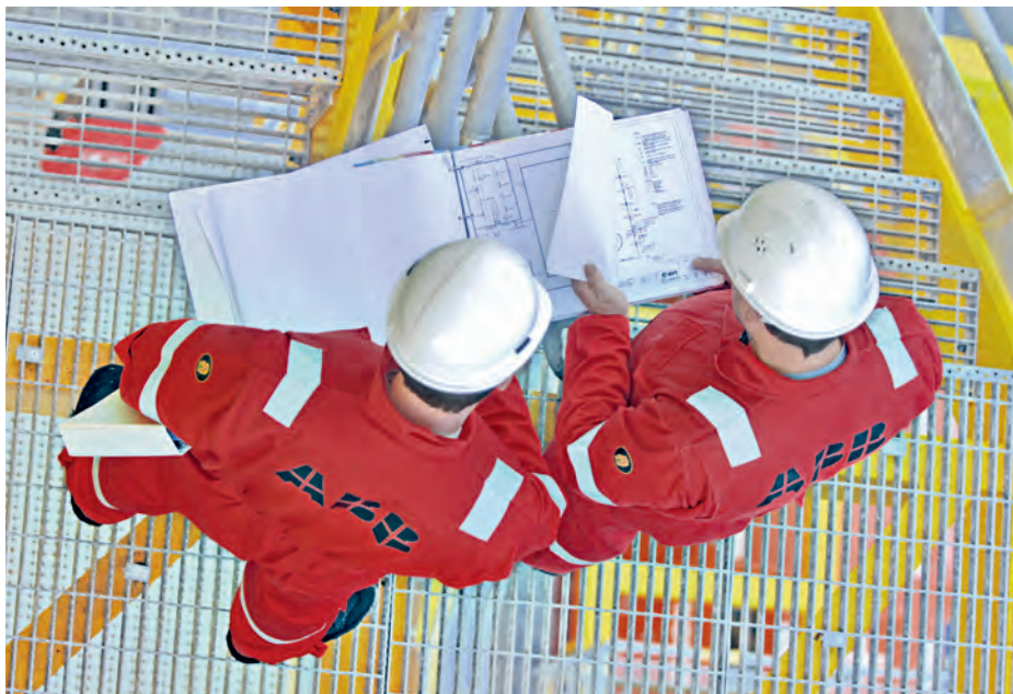
Mitarbeiter aus dem Bereich Transformatorservice auf der Plattform BorWin alpha in der Nordsee
