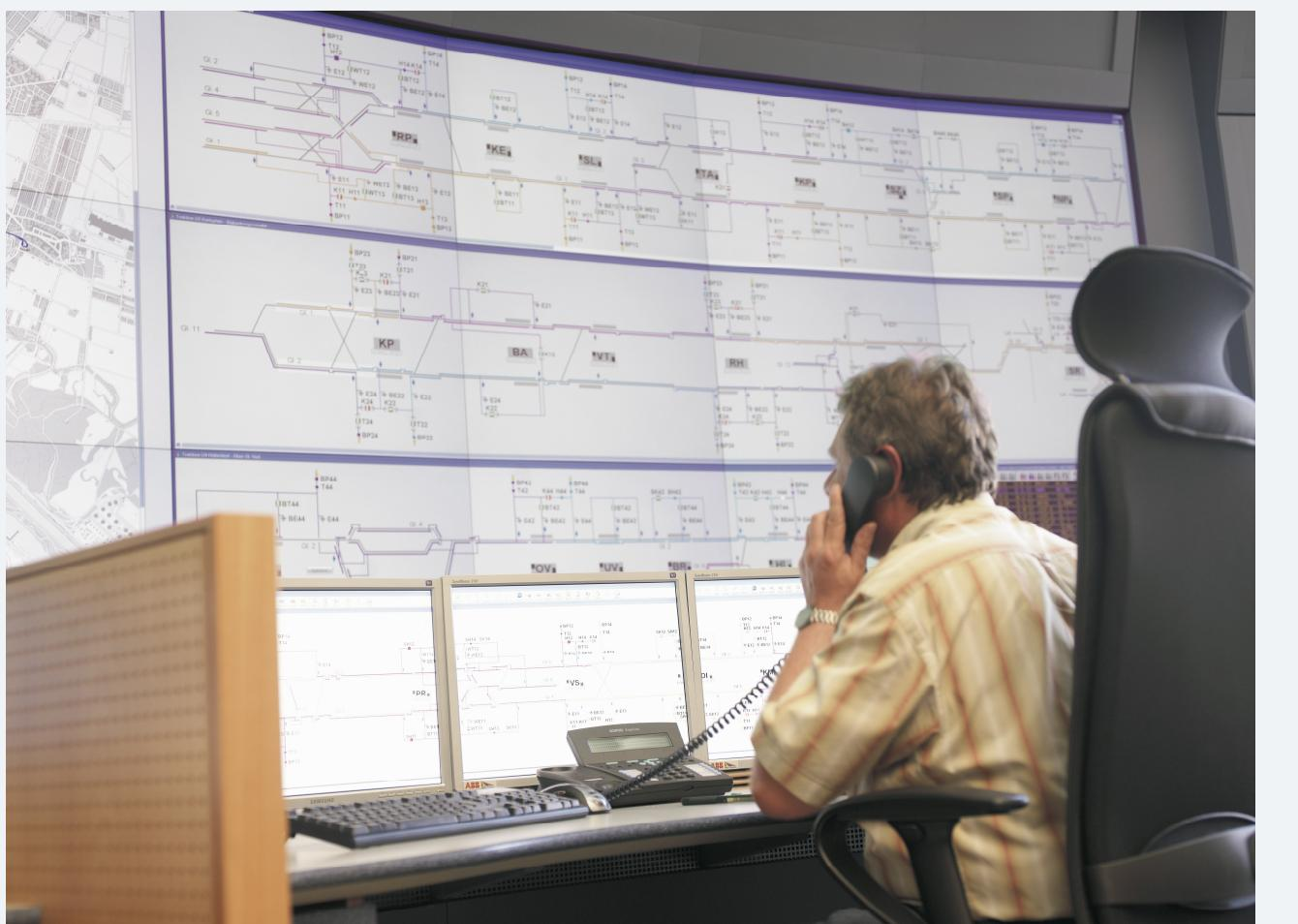
Auf den beiden 4x3-Arbeitsplätzen werden die Energiebereiche wie Mittel- und Niederspannung, Unterwerke, Gleichrichter, Traktionsstromversorgung, aber auch die Brandtunnellüftung gesteuert und überwacht. Auf der Fläche der 6x1-Arbeitsplätze werden Übersichten der jeweiligen U-Bahn-Linien dargestellt.
