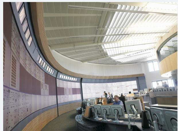
Auf der 50m breiten Rückprojektionswand werden Energie- und Stellwerksinformationen gemeinsam dargestellt. Damit ist für alle denkbaren Betriebssituationen eine optimale Übersicht über das gesamte U-Bahn-Netz gewährleistet.
