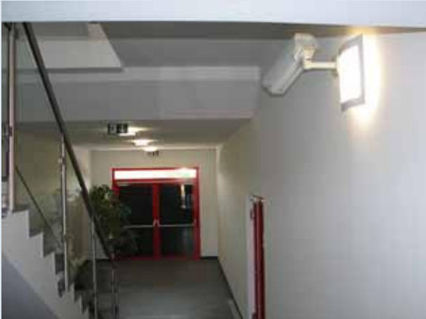
Videoüberwachung im Eingangsbereich
