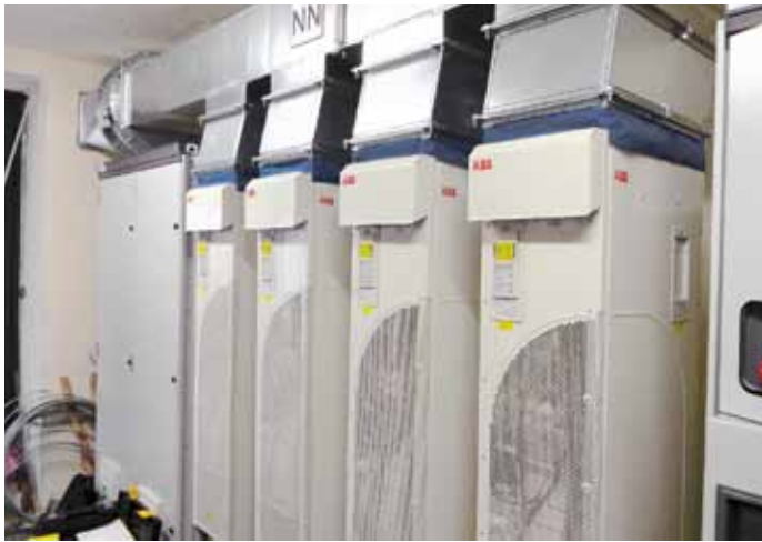
5 Meniče frekvencie ACS 800-02-0490-7 sú vzduchom chladené
