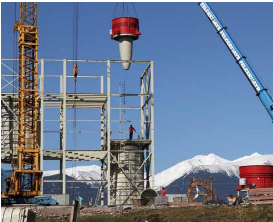
3 Jeden zo štyroch motorov ABB M3BP s ventilátorom už ide na svoje miesto v jednej zo slučiek
