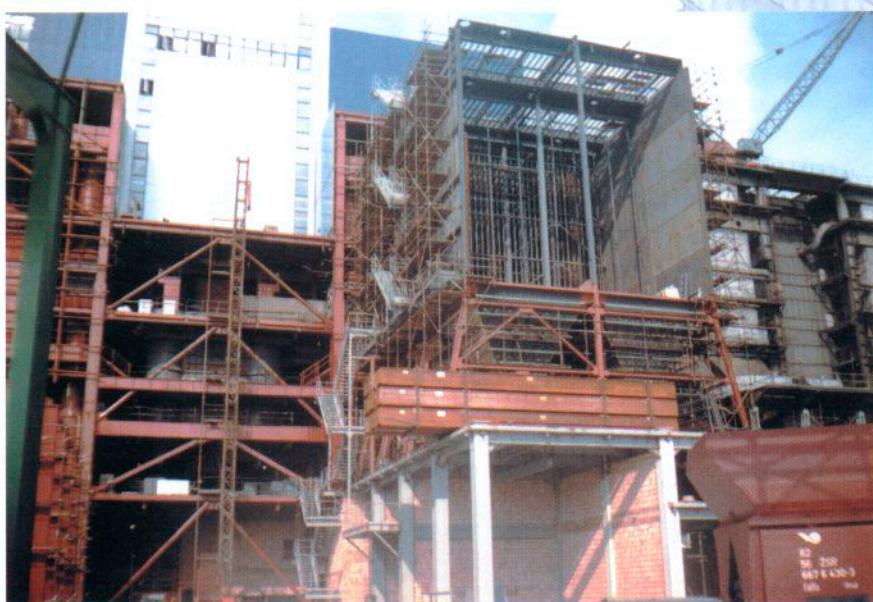
Obr. 1 - Montáž elektrostatického odlučovača ABB v Elektrárni Vojany
