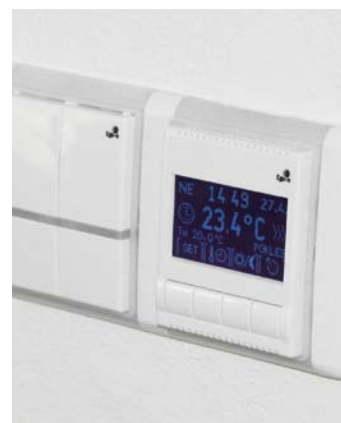
Nízkoenergetický dom vybavený tepelným čerpadlom riadi Ego-n®, ktorého „mozog“ je umiestnený v rozvážači a domáci ho ovládajú cez vypínače.
