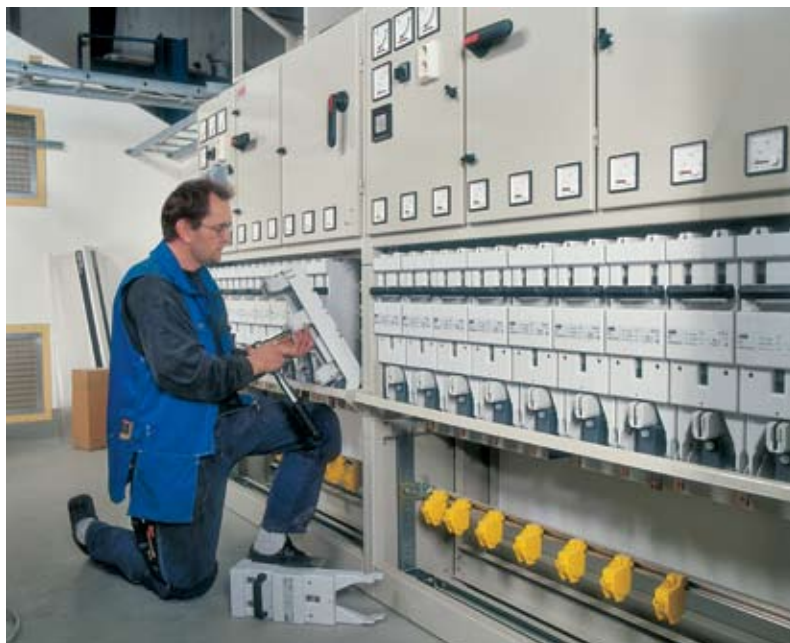
5 Vývody hlavných rozvádzačov so systémom IP vo Švédsku
