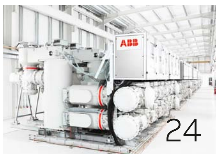
Vysokonapäťový plynom izolovaný rozvádzač ELK-04
