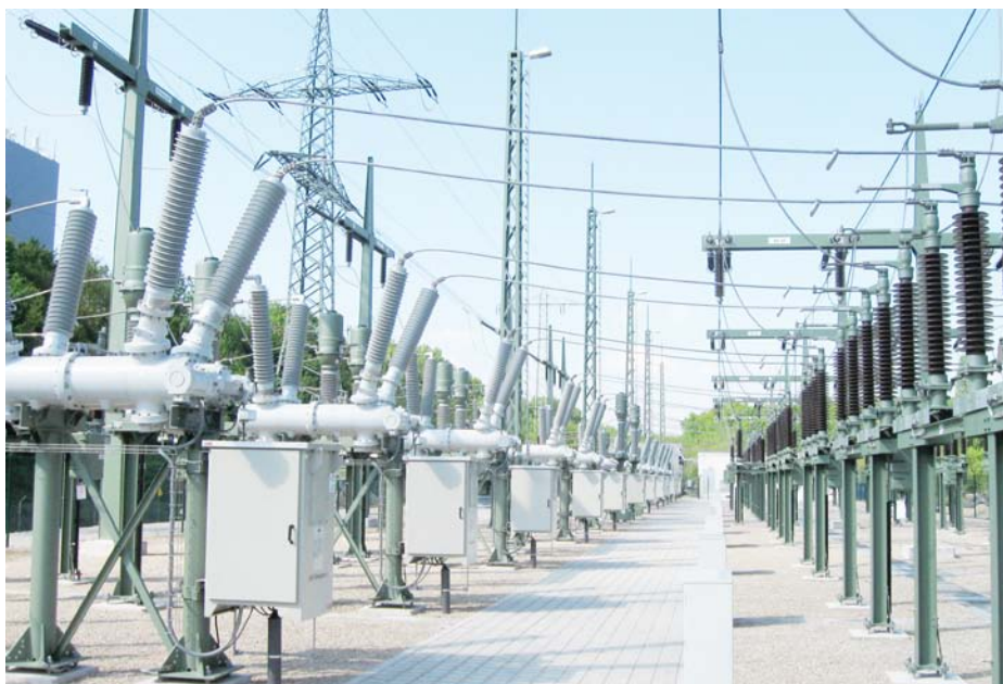
1 Dvojpolové vyhotovenie modulu PASS s pohonom Motor Drive
