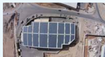
Fotovoltaická elektrárňa na streche skladu potravín v Jordánsku je vybavená invertormi ABB a mala by vykompenzovať až 77 % jej súčasnej spotreby elektrickej energie výrobou 714 000 kWh elektriny ročne.
