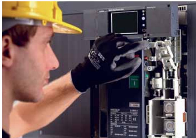
2 Dobre viditeľné podstatné informácie v centrálnej časti krytu a dvojité izolácia medzi čelom a živými časťami zabezpečujú úplne bezpečnú prevádzku
