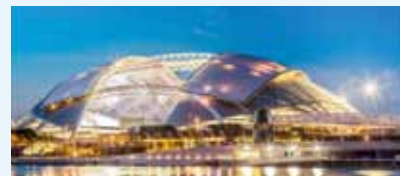
Riadiace a automatizačné zariadenia ABB stoja za otváraním tejto najväčšej pohyblivej strechy na svete bez vnútorných podpier, ktorá prekrýva národný štadión v Singapure.
