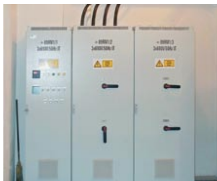
Instalovaný prepínací rozvádzač (vľavo) a frekvenčný menič ACS800-07LC-1370-7 (vpravo)
