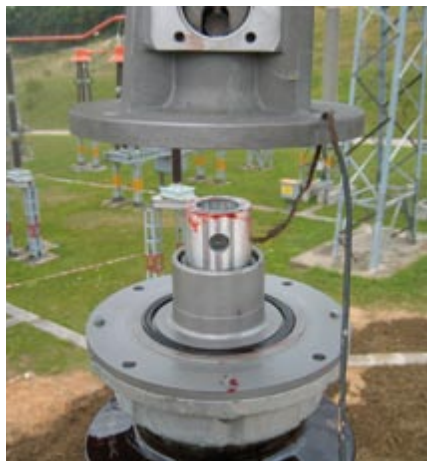
Obr.1 Demontáž pólu vypínača LTB 420 E2
