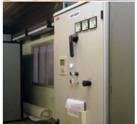
Obr.4 Jednosmerné meniče DCS800 zvládajú veľké mechanické výkony – pri kompaktných rozmeroch
