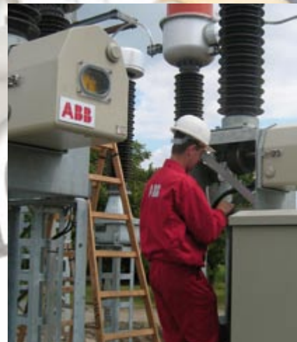
Obr.3 Pravidelná údržba VVN vypínača LTB s motorickým pohonom
