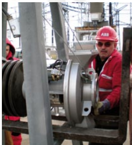
Obr.2 Generálna oprava ovládacieho pohonu VVN vypínača ELF SP
