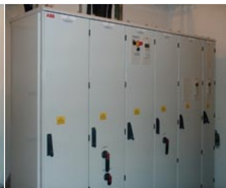
Instalovaný prepínací rozvádzač (vľavo) a frekvenčný menič ACS800-07LC-1370-7 (vpravo)
