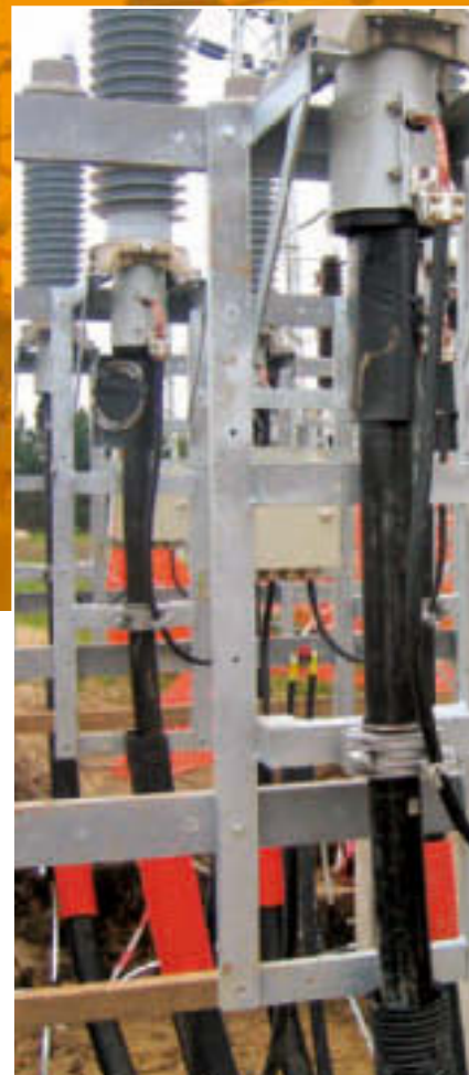
Obr. Káblová koncovka 110 kV
