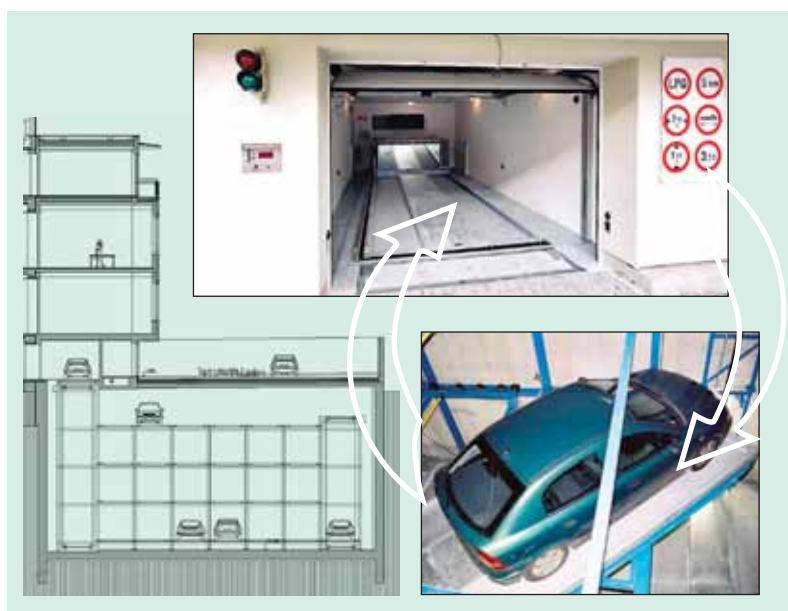
1 Vozidlo je po príchode odložené v podzemí a pred odchodom vysunuté na rampu
