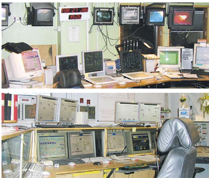
1a, 1b Dva príklady neprehľadných operátorských pracovísk
