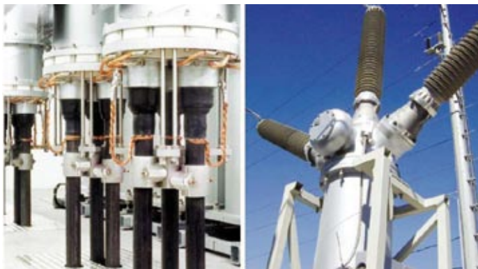
2 Príklady vývodových modulov: káblové (vľavo) a linkové (vpravo)
