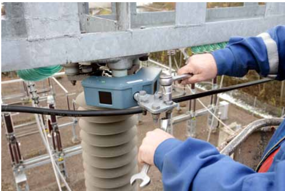
2 Inštalácia senzora EXCOUNT-II v inertnej polohe pre špeciálne aplikácie
