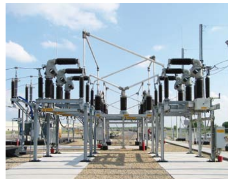
3 Príklad usporiadania rozvodne v zapojení do H pomocou modulov COMPASS
