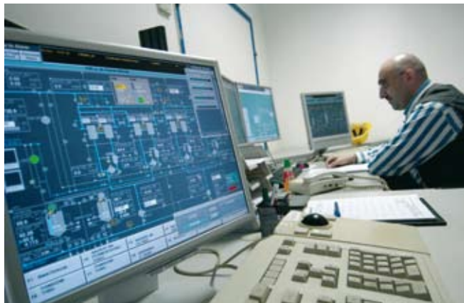
Obr.1 Riadiaci systém ABB MOD 300 riadi fermentáciu a izoláciu
