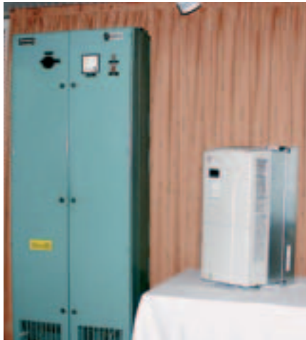
Obr. 1 Na ľavej strane je menič pre výkon motora 15 kW spred 30-tich rokov, na pravej strane je nový typ meniča (ACS800) pre výkon motora 70 kW
