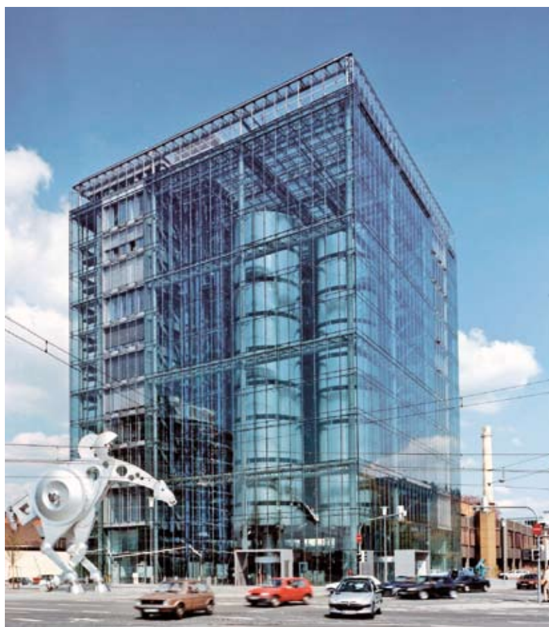
2 V Print Media Academy zabezpečuje systém EIB rad regulačných funkcií budovy
