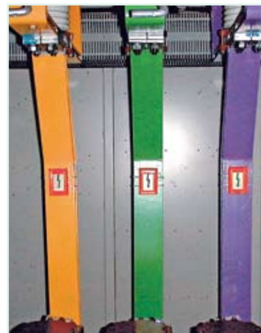
2 Pasívne indikátory VisiVolt™ po nainštalovaní nepotrebujú prakticky žiadnu údržbu
