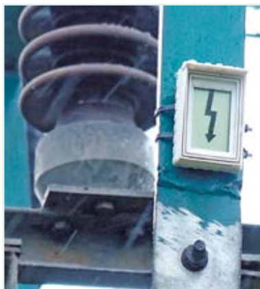
2 Pasívne indikátory VisiVolt™ po nainštalovaní nepotrebujú prakticky žiadnu údržbu
