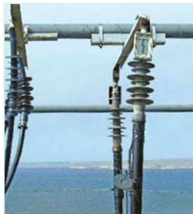
2 Pasívne indikátory VisiVolt™ po nainštalovaní nepotrebujú prakticky žiadnu údržbu
