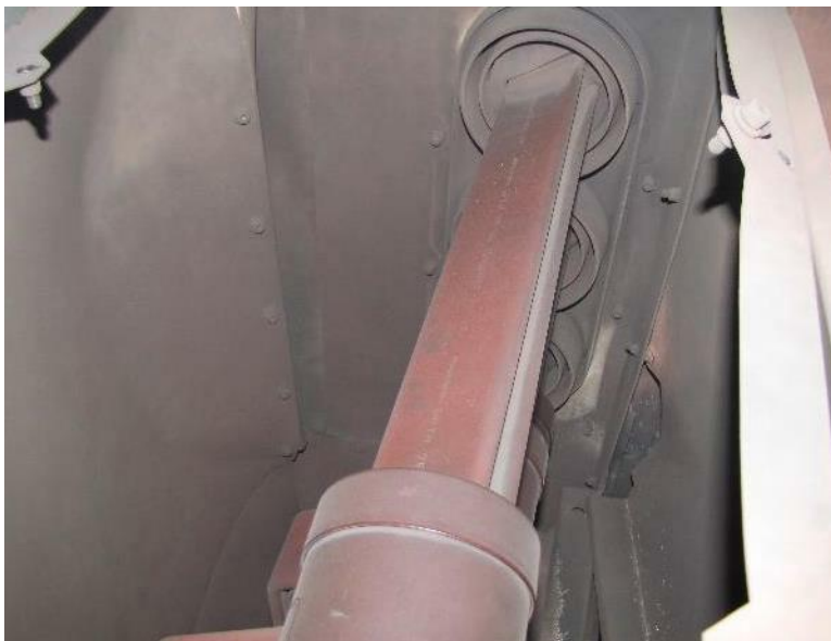
Compartimento de barras después de prueba (50 kA / 100 ms)
