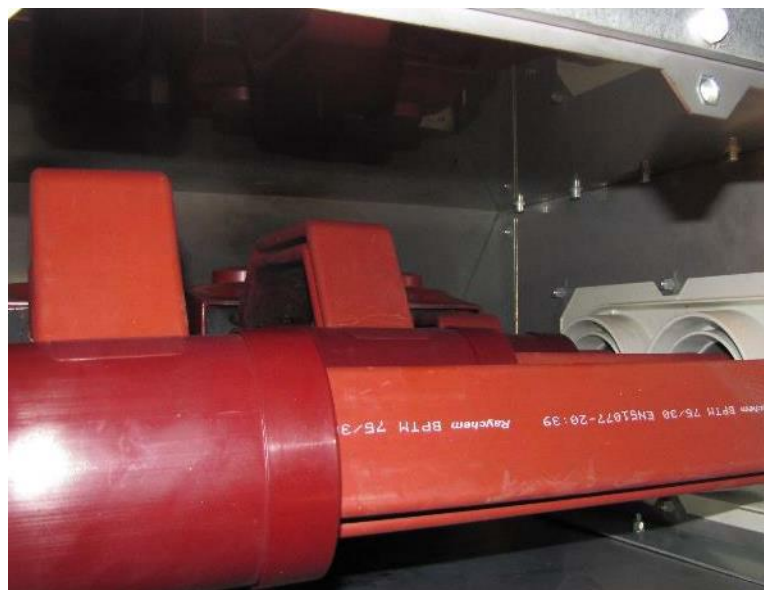
Compartimento de barras después de prueba
