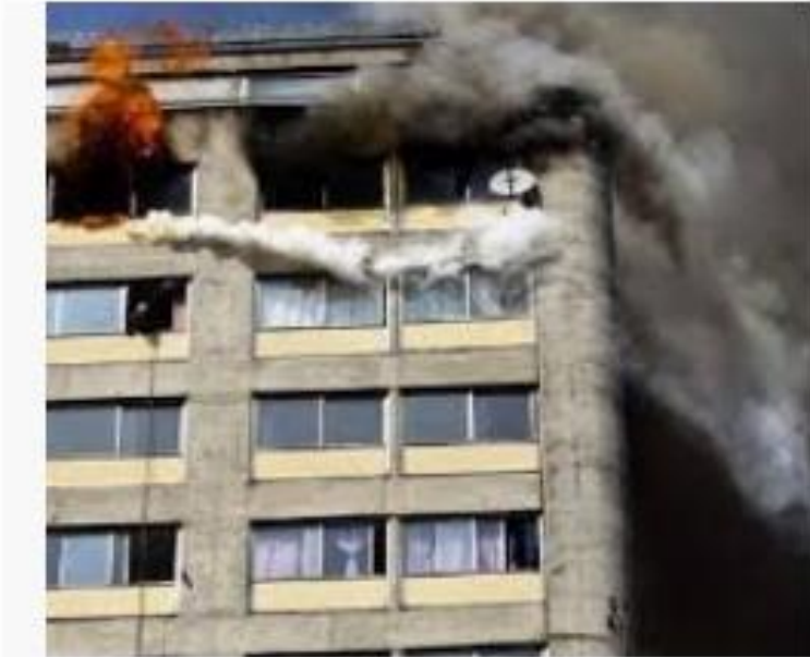
Corto circuito, causante de incendio en Tla... informador.mx
