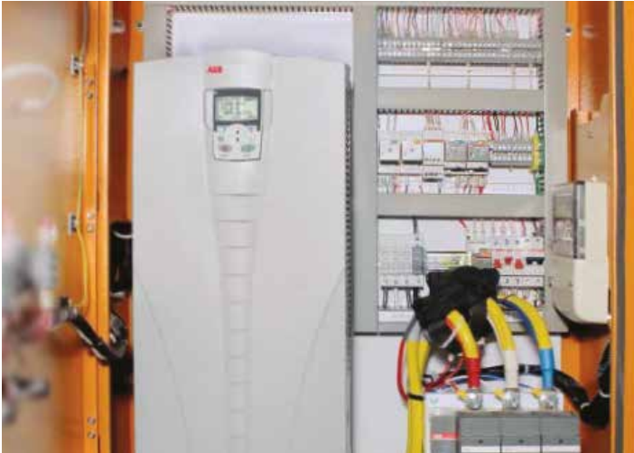
ไดร์ฟถูกติดตั้งใกล้กับมอเตอร์ของบิ่มน้ำ และตั้งค่าให้เริ่มทำงานอีกครั้งโดยอัตโนมัติเมื่อจำเป็น ทั้งยังช่วยลดแรงงานในการควบคุมระบบชลประทานได้
