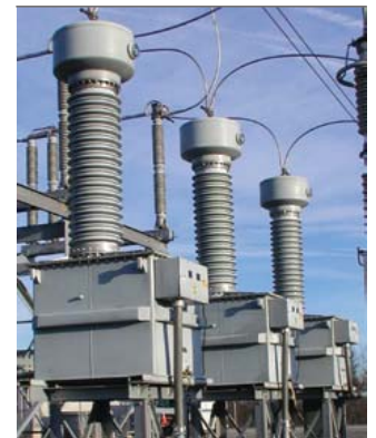
รูปที่ 1 แสดงการติดตั้ง กับดักฟ้าผ่า ให้ใกล้กับหม้อแปลงแรงดัน SSVT
