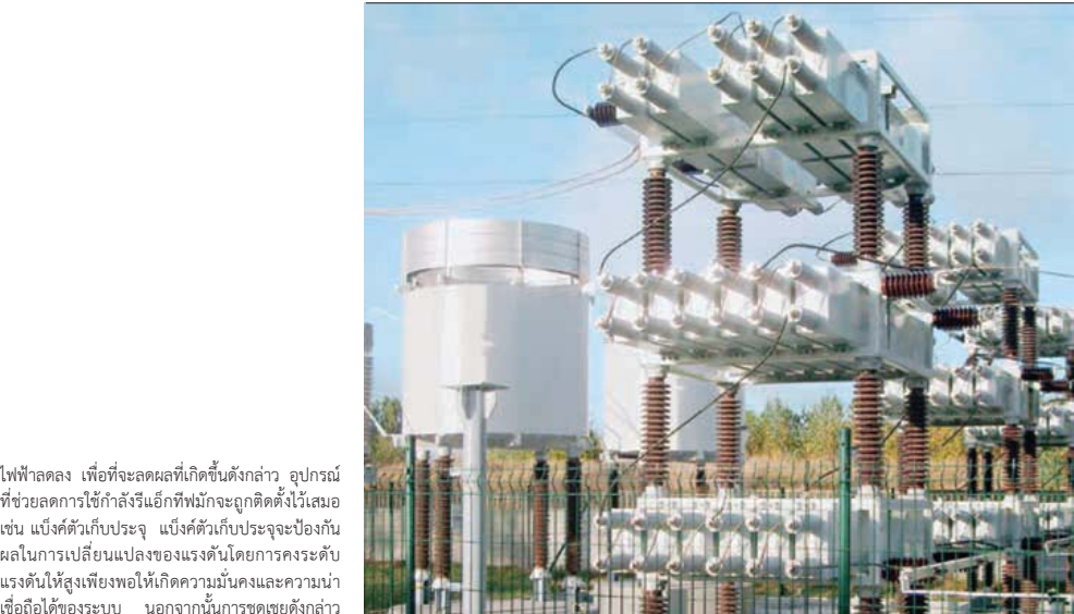
รูปที่ 4 การติดตั้งตัวกรองแบบพาสซีฟ 110 kV ในโปแลนด์
