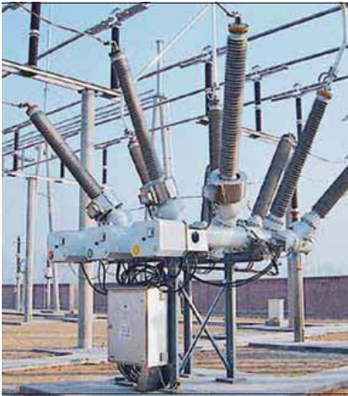
รูปที่ 8 1,100kV UHVAC GIS แบบไฮบริดซึ่งถูกออกแบบโดยเอบีบีสำหรับสถานีไฟฟ้าย่อย Jingmen ในประเทศจีน
