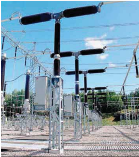
รูปที่ 4 เซอร์กิตเบรกเกอร์แบบ SF6 ที่แรงดัน 420 kV ด้วยตัวตัดกระแส 2 ยูนิต์ต่ออุโมงค์กัน
