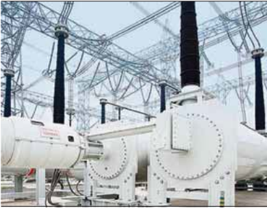
รูปที่ 8 1,100kV UHVAC GIS แบบไฮบริดซึ่งถูกออกแบบโดยเอบีบีสำหรับสถานีไฟฟ้าย่อย Jingmen ในประเทศจีน
