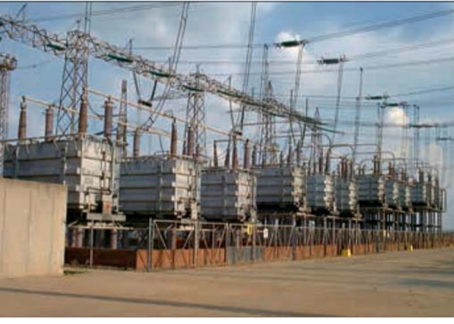
รูปที่ 5 วาล์วแบบไทรสเตอร์ติดตั้งการแจ้งซึ่งกันและกันและระบายความร้อนด้วยน้ำมันในการต่อเชื่อมโยง Cahora Bassa HVDC ระหว่างประเทศโมซัมบิกและประเทศแอฟริกาใต้
