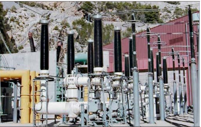
รูปที่ 3 สถานีไฟฟ้าฟิลุส La Muela ในประเทศสเปน : กลไกการทำงาน HKA8 ถูกแทนที่ด้วย HMB8 สำหรับเบรกเกอร์รุ่น SL3-2
