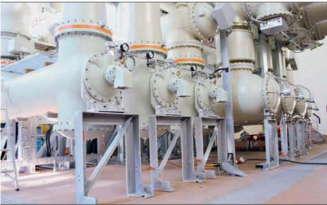
รูปที่ 2 สวิตช์เกียร์ขนาด 132kV ภายในห้องสวิตช์เกียร์ของสถานีไฟฟ้าฟิลุส ในประเทศสวิตเซอร์แลนด์ เซอร์คิตเบรกเกอร์รุ่น SL3-2 และกลไกการทำงาน HKA8 ถูกแทนที่ด้วยเซอร์คิตเบรกเกอร์รุ่น SP3-1 แบบห้องอาร์กเดี่ยวที่มีกลไกการทำงาน HMB4
