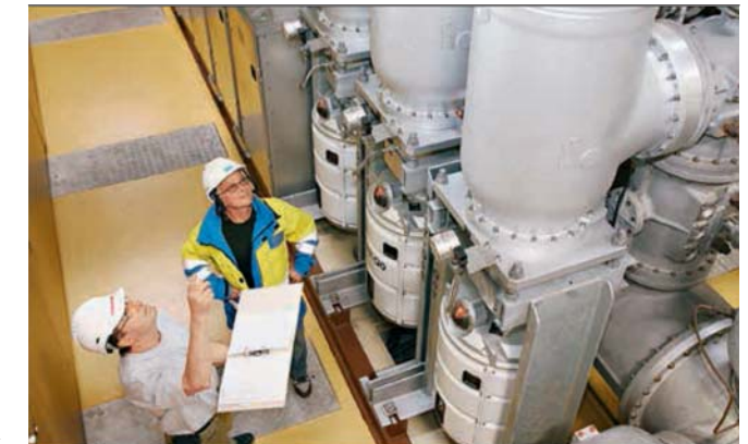
รูปที่ 1 สวิตซ์เกียร์ฉนวนก๊าซที่สถานีไฟฟ้าย่อย La Foretaille ในประเทศสวีตซ์เกียร์แลนด์ เซอร์กิตเบรกเกอร์รุ่นเก่าชนิด SN ถูกแทนที่ด้วยชนิด ELK SP2-1 ด้วยกลไกการทำงาน AHMA
