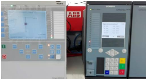
Fig. 17 Interoperabilidad ABB - Siemens durante desarrollo de ingeniería
