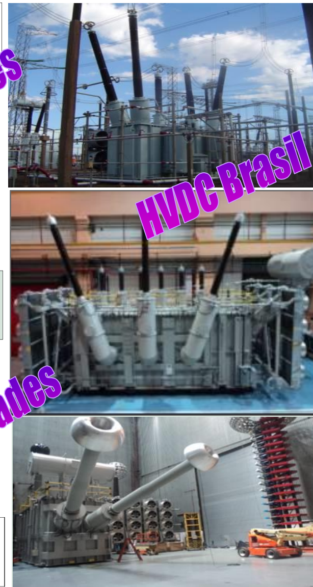
RIO MADEIRA Bipolo HVDC Transf Convertidor, 1Ø, 292MVA 550kV AC / 600kV DC
