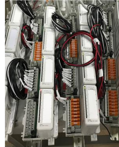
Módulos E/S S800 pre cableados y en riel DIN
