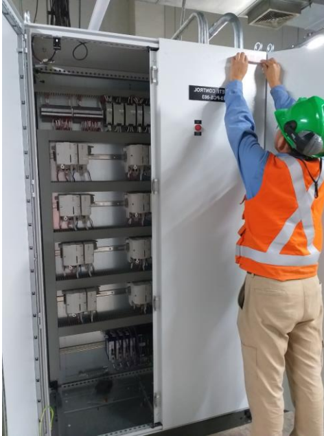
Gabinete de controlador instalado en planta
