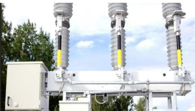
Cuchillas de puesta a tierra operadas desde sala de control
