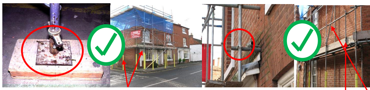
(a) Soporte de pie sólido (b) Postes verticales + sujeciones (c) Asegurados por amarres (d) plataforma, tabloncillos de pie / barandillas
